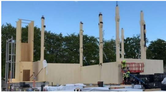
Figure A-21: Erection of columns and walls ( Nu Sätts Trästommen På Plats i Sege Park , 2021 )
