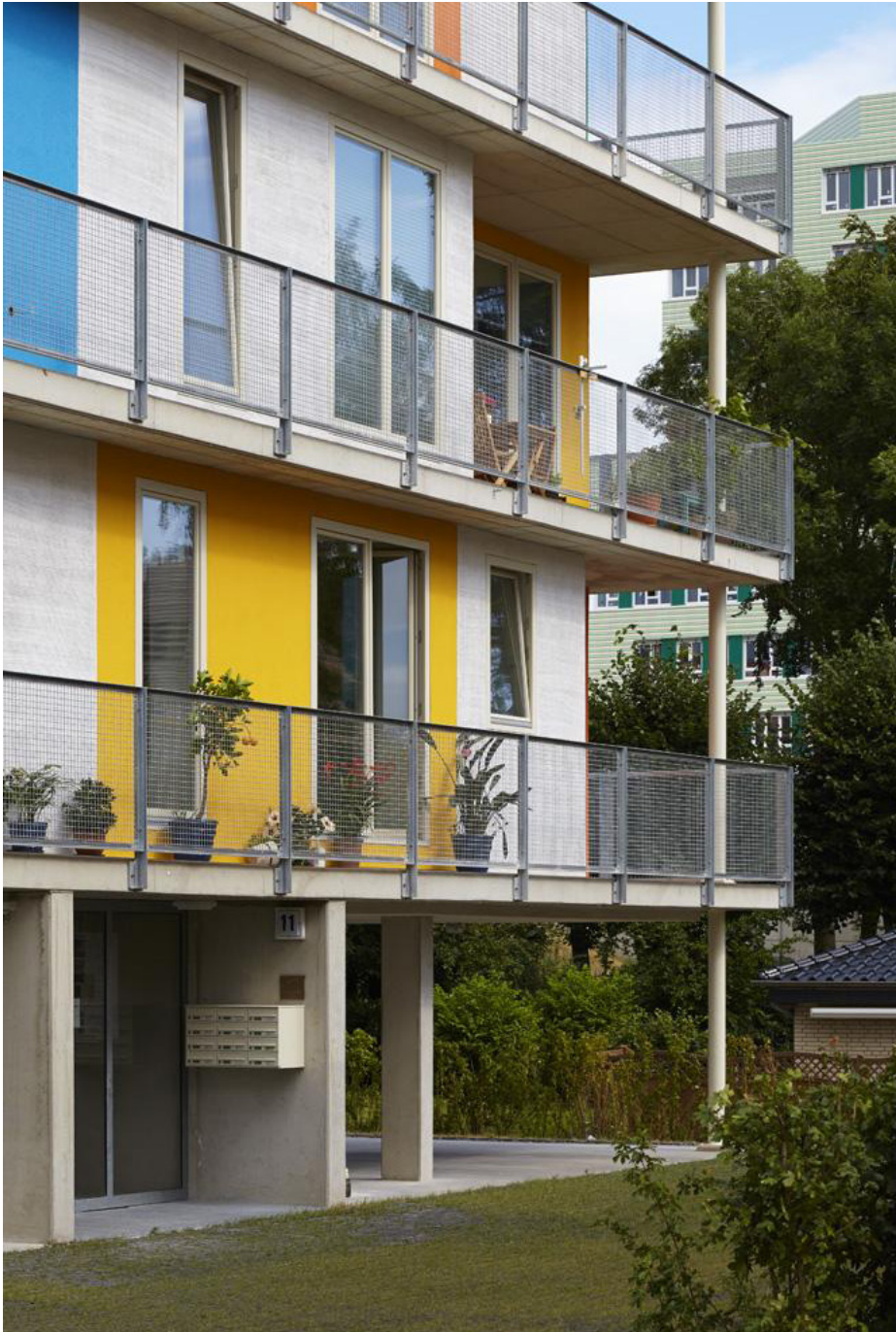
Fig. 11. Wrage, G (2013). Exterior of Grundbau und Siedler
