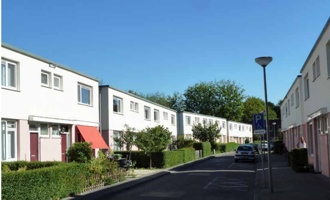
FIGUUR 7.6 Controle in de Roze Kampen
