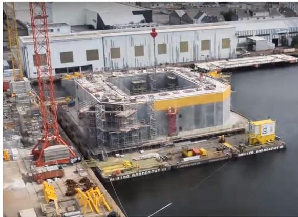
Figure A-12 - Construction phase FLOATGEN foundation (Floatgen.eu)
