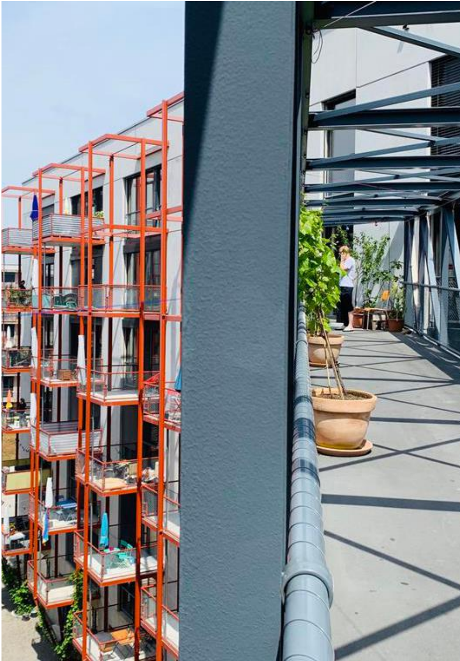
Fig 2.1 : Zwicky-Süd Bridge view @ Kraftwerk1
