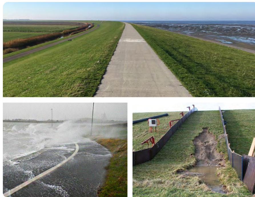
Figuur 2: Boven: Een weg op een zeedijk met grasbekleding. Foto door Vera van Bergeijk. Linksonder: Overslag over een dijk met een weg op de kruin. Bron: https://coastalpartners.org.uk/ . Rechtsonder: Erosie van de grasbekleding bij de binnenteen tijdens een overslagexperiment. Bron: Hoffmans (2014).
