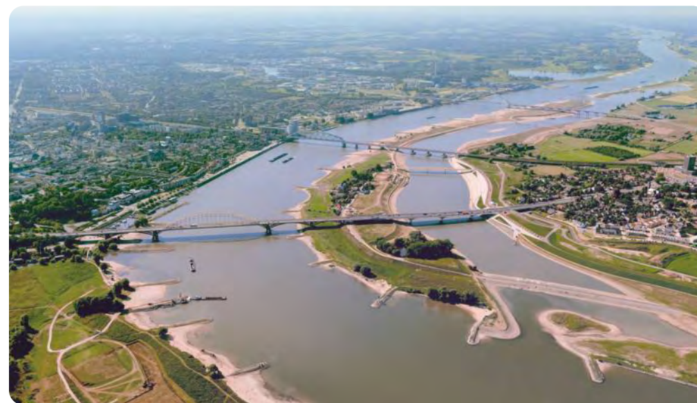
Huidige impressie van de by-pass bij Nijmegen-Lent, met de oude rivierdijk nog zichtbaar tussen de twee riviertakken. Foto door DaMatrix van Wikimedia Commons, CC BY-SA 4.0.
