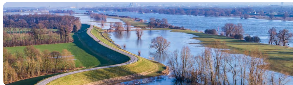
Locatie van een toekomstige dijkversterkingsproject langs de Waal. Foto via dijkversterkingwolferensprok.nl .
