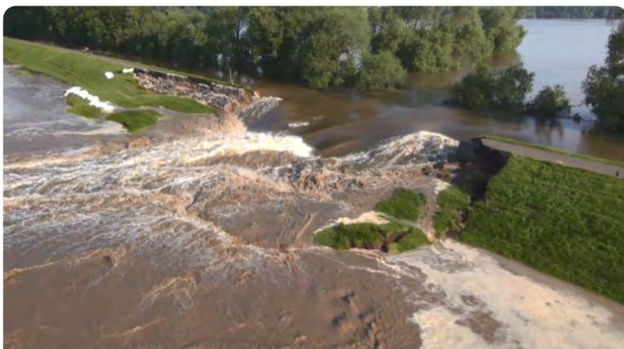
Dijkdoorbraak door instabiliteit binnentalud. Foto door Weichel (2013).
