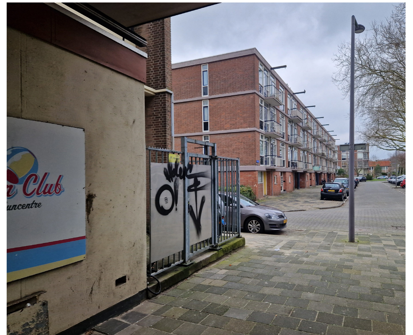
4.61 - Maintenance of Zuidwijk
