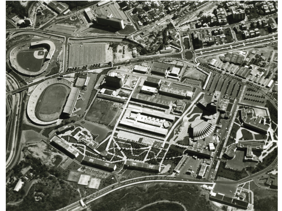
Figuur 2.22. Ciudad Universitaria Caracas (Source http://www.redfundamentos.com/blog/es/obras/detalle-135/ )
