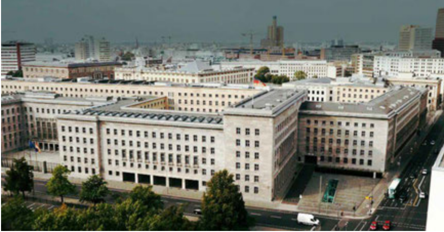
FIG. 1 Reichsluftfahrtministerium 1936–45; Russische Militärverwaltung 1945–48; Finanzministerium der DDR 1949–90; Zentrale der Treuhandanstalt 1992–97; Finanzministerium der BRD seit 1999
