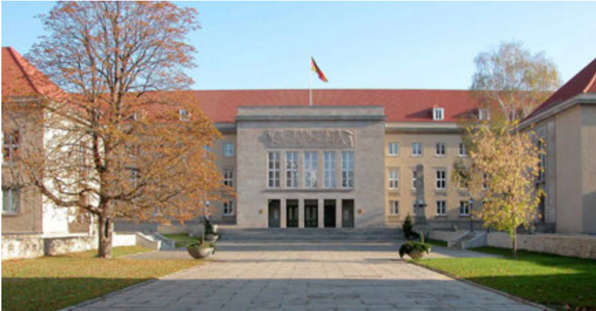
FIG. 2 Wehrkreiskommando Dresden 1938–45; ein Viertel kriegszerstört, detailgenaue Rekonstruktion 1946; Sitz der sächsischen Landesregierung 1946–58; Militärakademie Friedrich Engels der NVA 1959–89; Verwaltungsgebäude der Bundeswehr seit 1990
