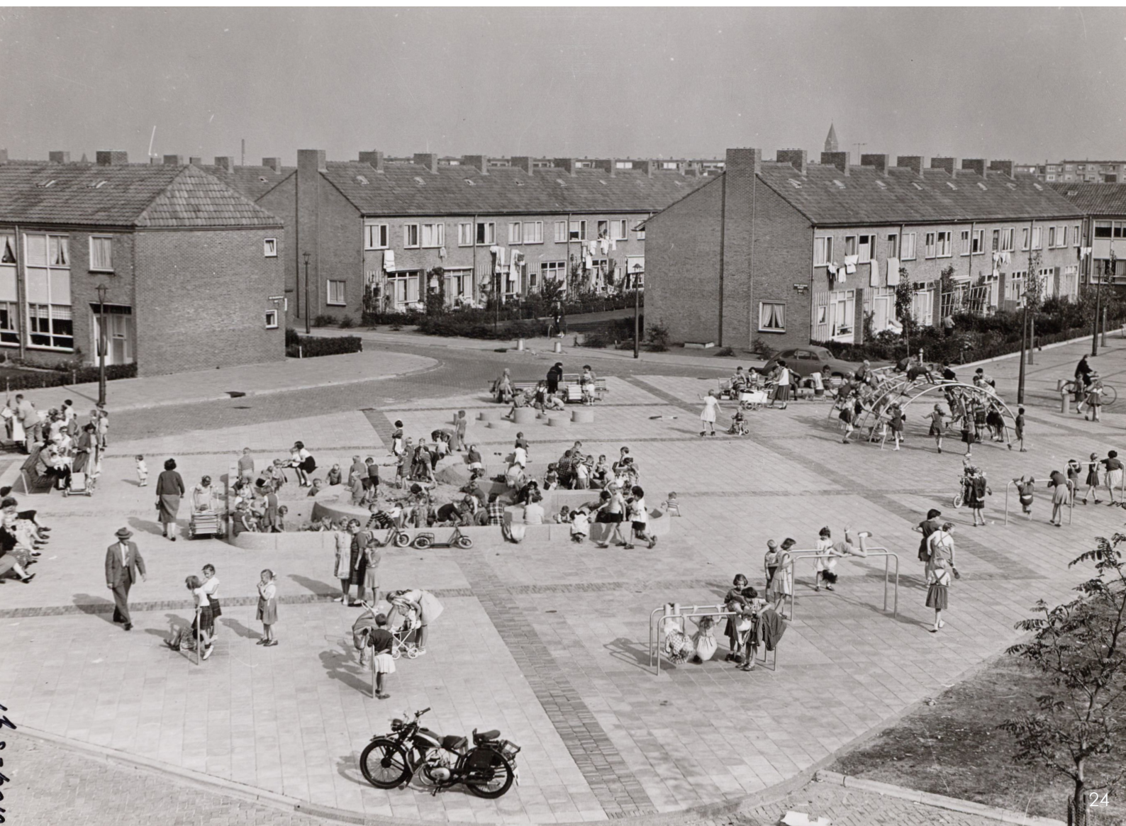
Figure 26. The low-rises on Nico Snijdersstraat by Blomhert, Groenewegen and Van Woerden. SAA.
