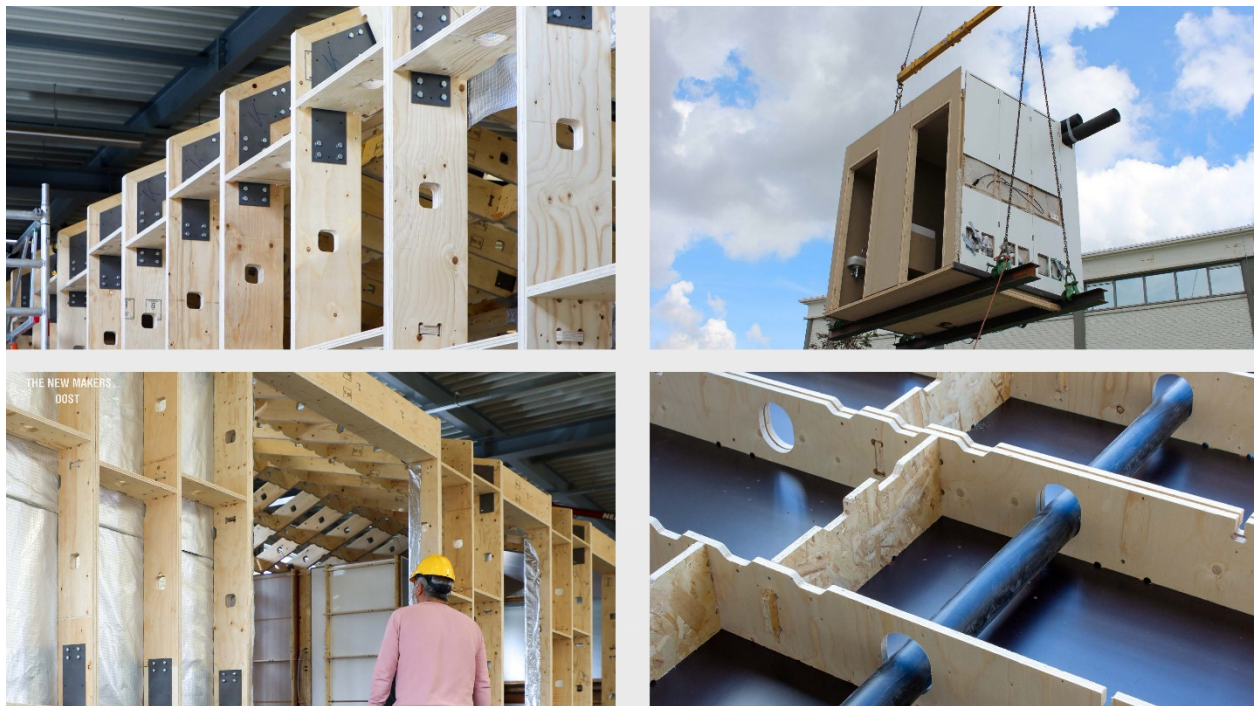
Figuur 7. Nadat het ontwerp is gemaakt wordt met CNC-technologie alle biobased componenten in 2D gesneden, verpakt en naar de bouwplaats vervoerd voor montage. Bron: website Uuthuske.nl
