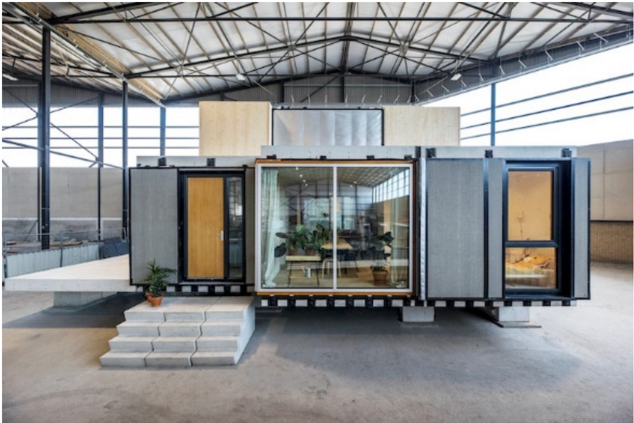
Figuur 8. Mock up van een MOOS module. Links de standaard module, midden de woonmodule en rechts de extra slaapmodule. Bron: website https://inthemiddlefourstreet.nl
