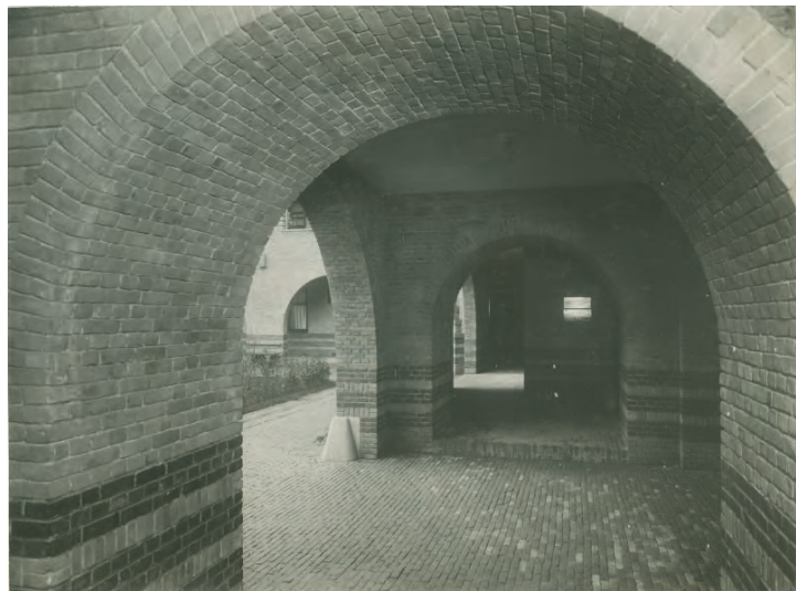
Matheneserhof, Spangen, Rotterdam Bron: Stadsarchief Rotterdam, foto: Fototechnische Dienst, F.H. van Dijk
