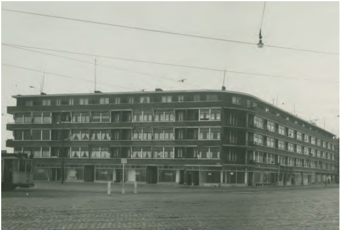
Marconiplein, Rotterdam Bron: Stadsarchief Rotterdam, foto: Fototechnische Dienst, F.H. van Dijk
