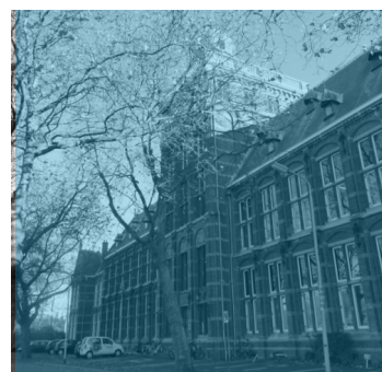
Exterieur impressie Kanaalweg
