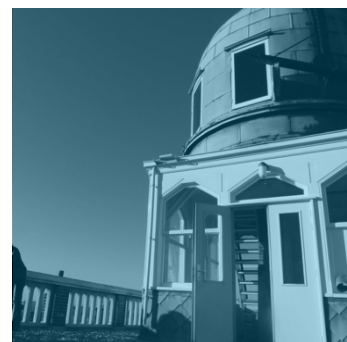
Exterieur impressie Kanaalweg
