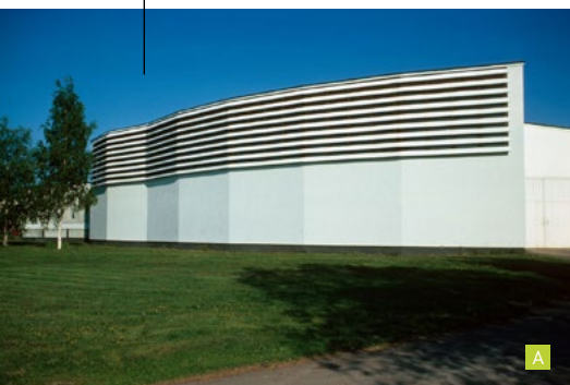
Figuur 5: Bibliotheek Seinäjoki, Aalto (1965); 5a Zuidgevel; 5b Interieur aan zuidgevel; 5c Doorsnede zuid-noord
