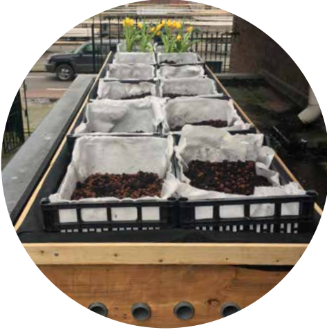
[Figuur 3.4 - Doe-het-zelf groendak, gemaakt van gebruikte marktkratten. Foto: auteurs, 2020]
