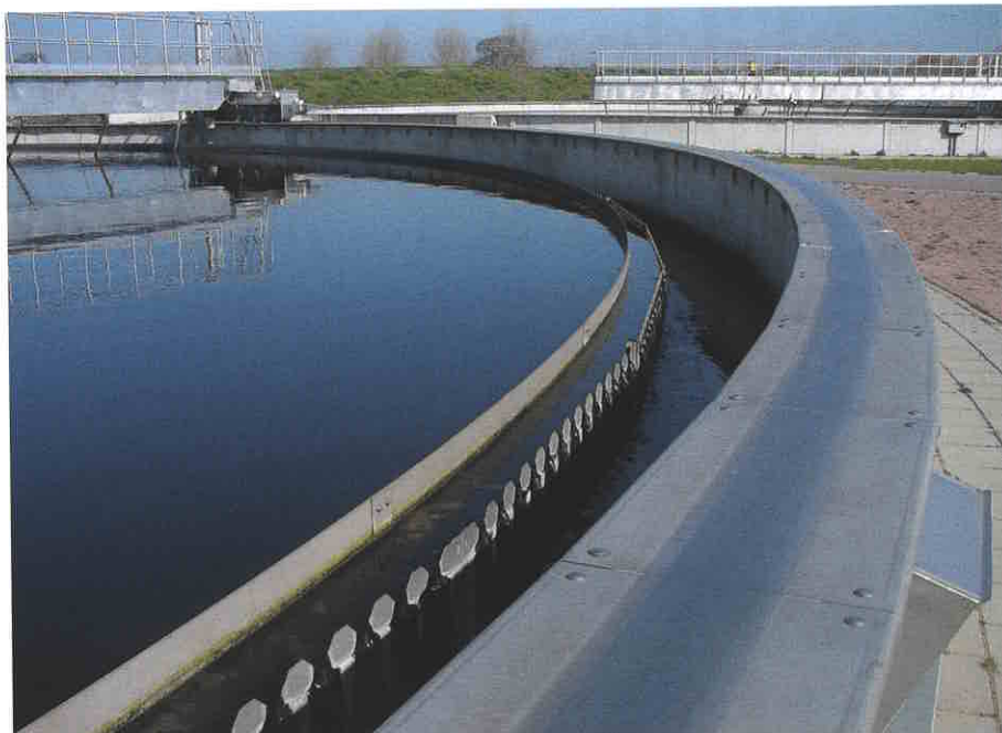
Een zuiveringsconcept met HACP's kan, bijvoorbeeld, worden nageschakeld achter een nabezinktank.
