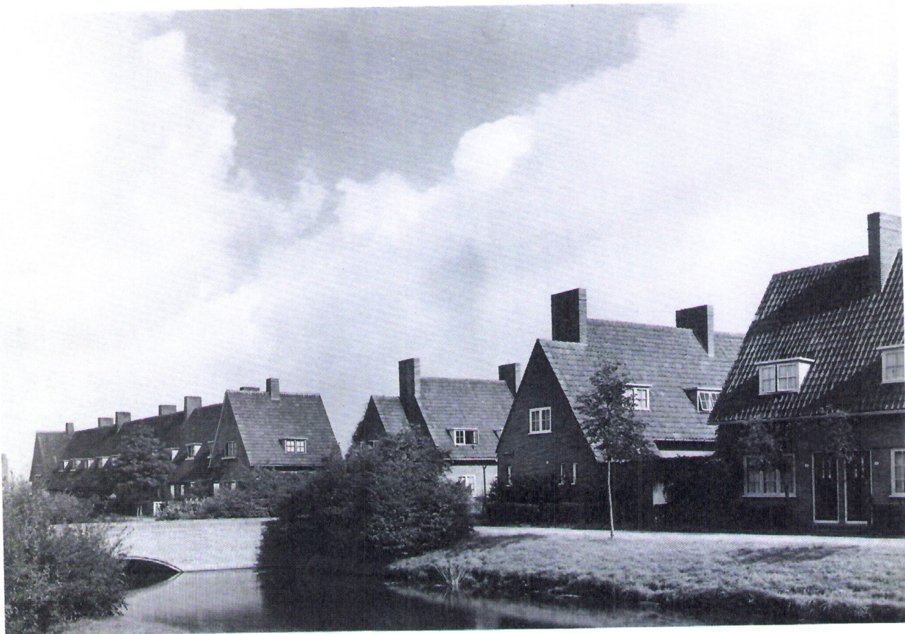
157 Tuindorp Vreewijk in Rotterdam (ca. 1920). Een van de vroege tuindorpen met arbeiderswoningen.
