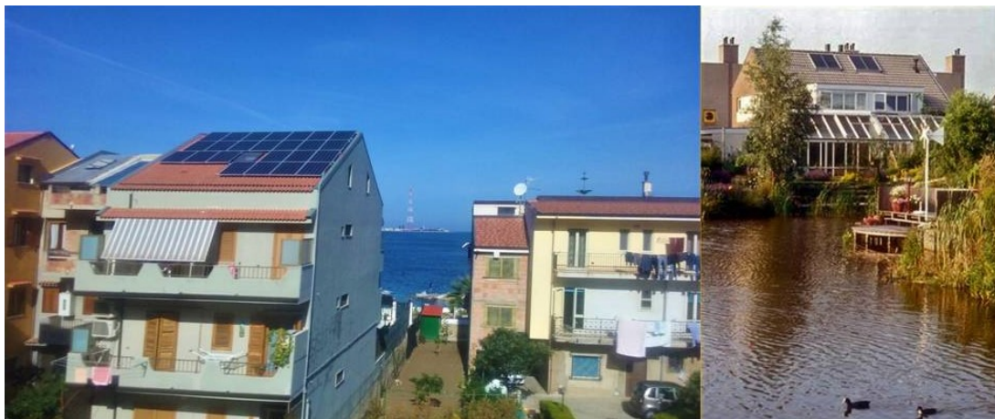
Figura 2 | Abitazioni a Villa San Giovanni (RC) a sinistra, edifici residenziali a Ecolonia, sud Paesi Bassi, a destra. Fonte: parte sinistra, S. Aragona, parte destra L. Kroll.
