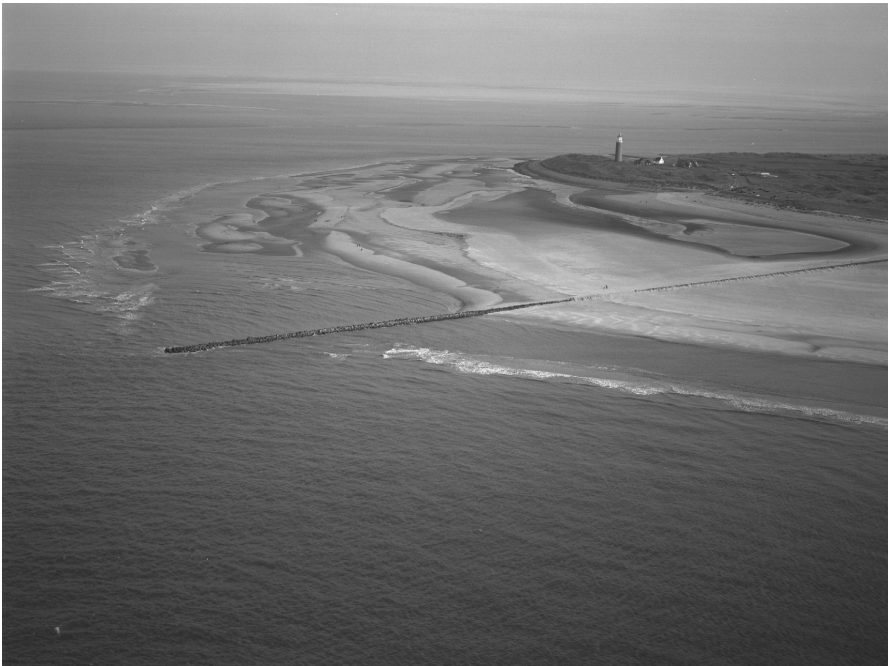
Long groyne at Eijerland (example B3, photo Rijkswaterstaat)
