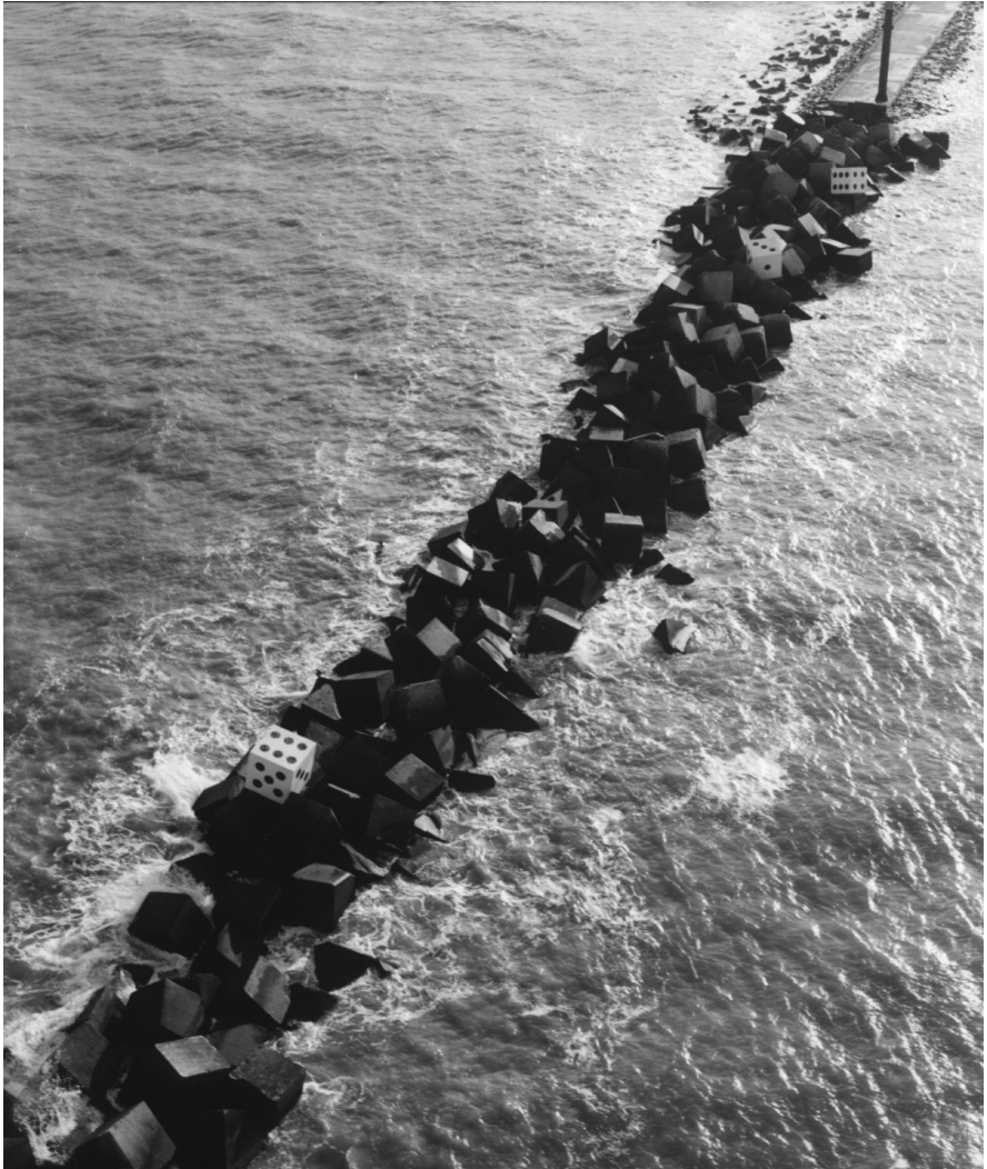
Dice block on the breakwater of Hook of Holland (4000-018 Bart van Eyck Beeldbank Rijkswaterstaat)
