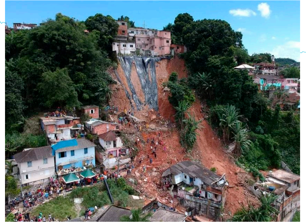
Landslide in Morro São Bento, Santos, State of São Paulo (Felixx Drone, 2020)
