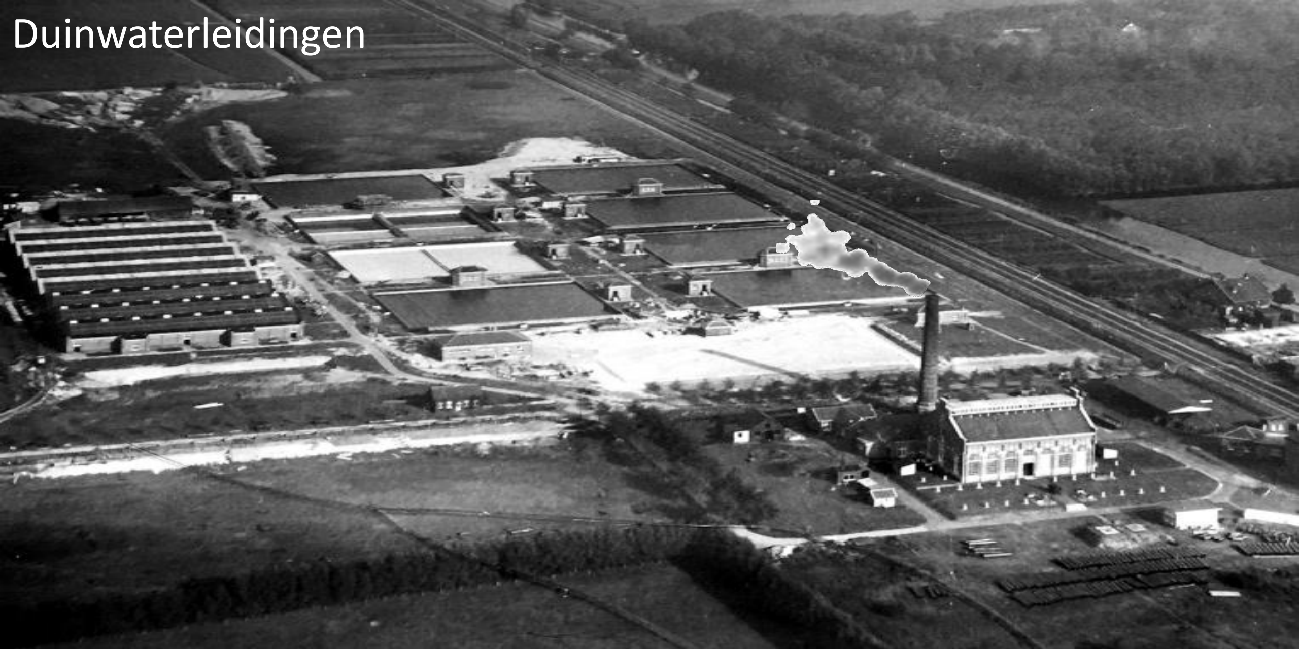
Het eerste waterleidingbedrijf van Nederland. Pompstation Leiduin te Vogelenzang.
