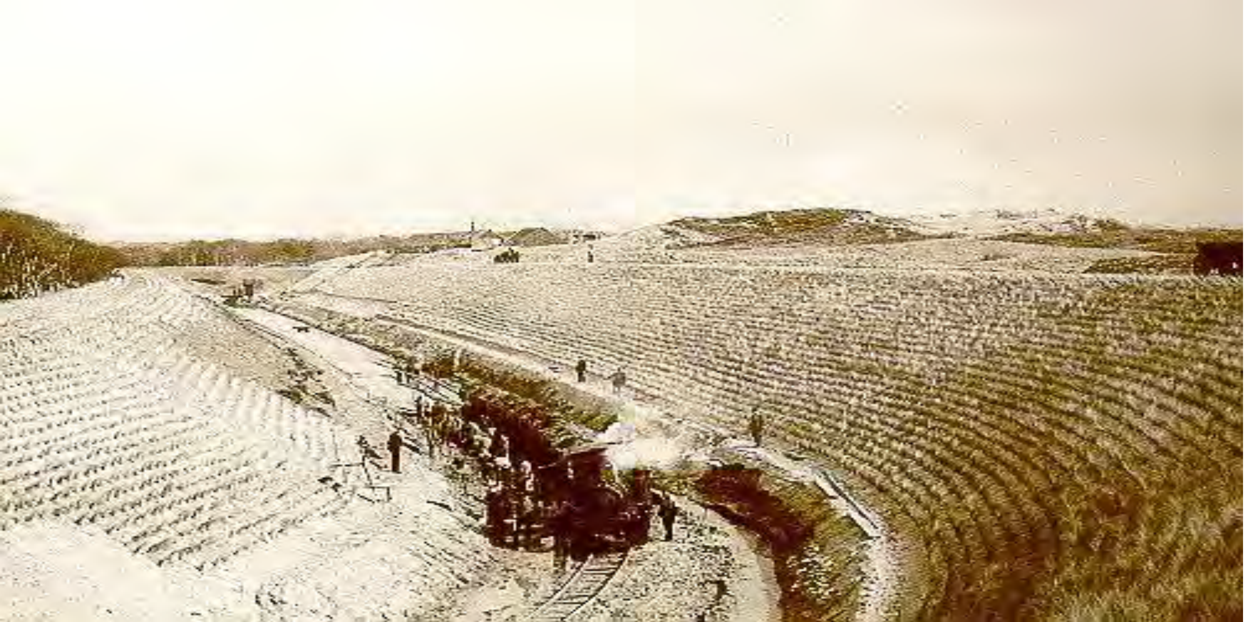
Aanleg winkanalen in de duinen 1850-1870.
