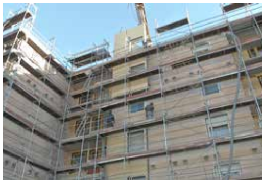
FIG. 7 SINFONIA project – panel installation (source: Benedikter Architekten)
