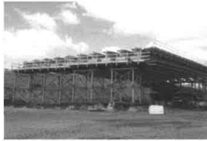
写真-2 桁の仮置き
