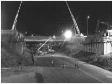
写真-1 既存の橋の撤去
