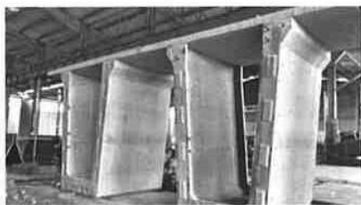
写真-4 UHPCセグメント
