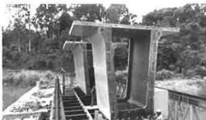
写真-5 セグメント架設
