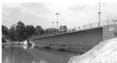
写真-6 完成全景
