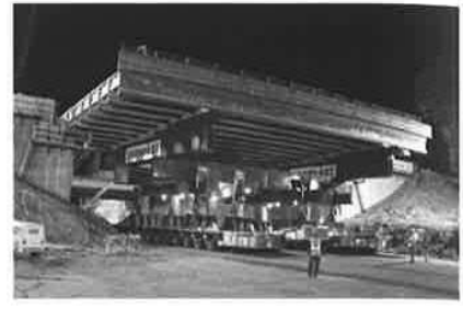
写真-3 SPMTでの架設
