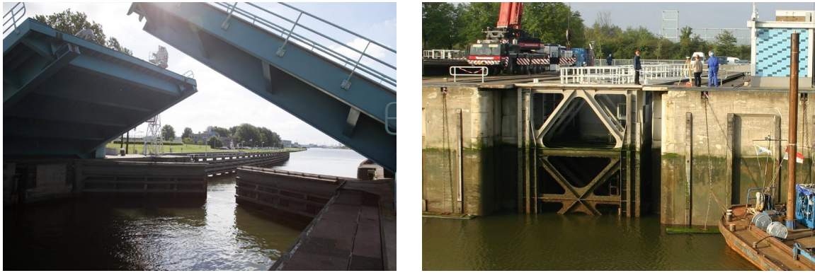
Figure 6.7: Sluice gates from the Terneuzen lock complex in the Netherlands (Gelders Staalstraal- en Schildersbedrijf B.V. (2019)).
