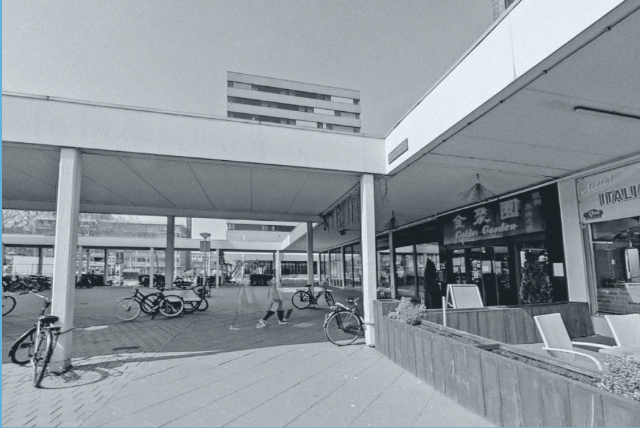
Delflandplein, Amsterdam Nieuw-West (bron: google maps)
