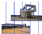
1939 - 1940 Porterías by Calle 26 and Calle 45
