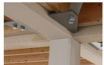
Close up of the column-beam-floor detail (Nationale Staalprijs, 2012)
