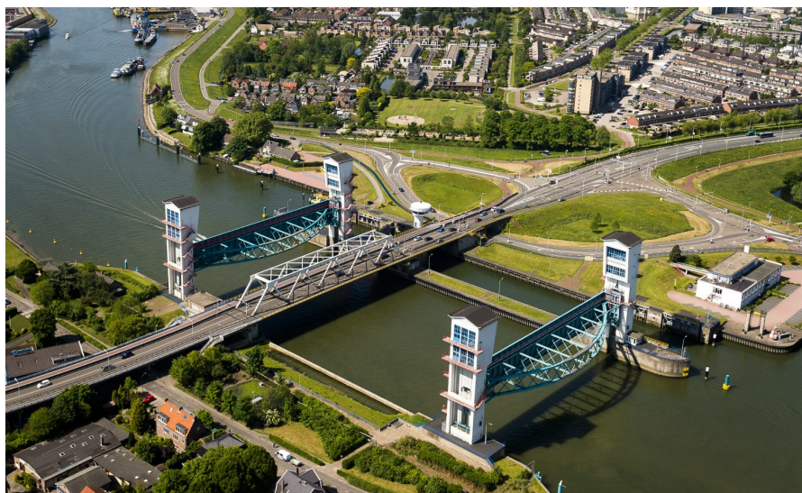
Figure 2.4: The Hollandsche IJssel barrier (Rijkswaterstaat, 2018a).
