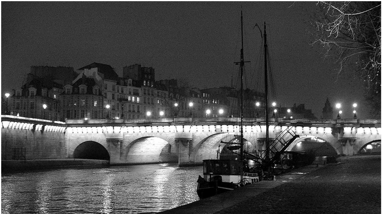
Εικ. 4.9. Η γέφυρα του Pont-Neuf, Παρίσι https://upload.wikimedia.org/wikipedia/commons/f/f1/Le_Pont_Neuf_la_nuit%2C_Paris.JPG
