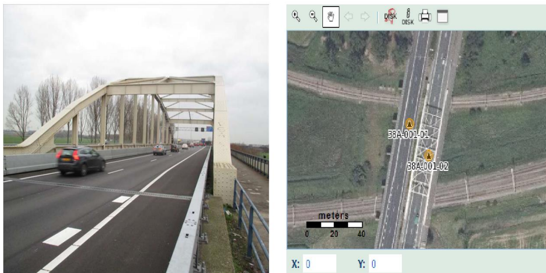
Figure 38 Project 3 Groenebrug Oost Viaduct
