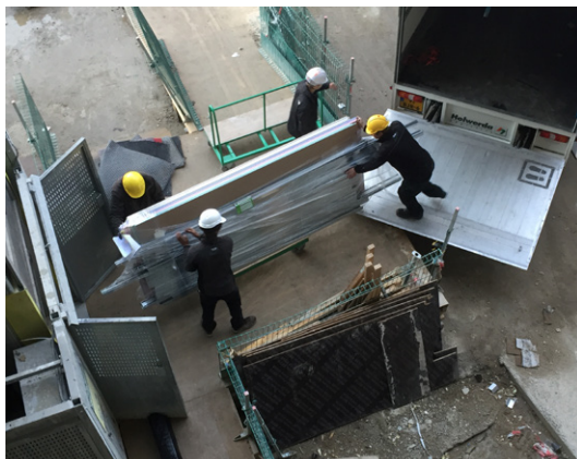
Figuur 12: Laden en lossen op de bouwplaats, bron Dura Vermeer
