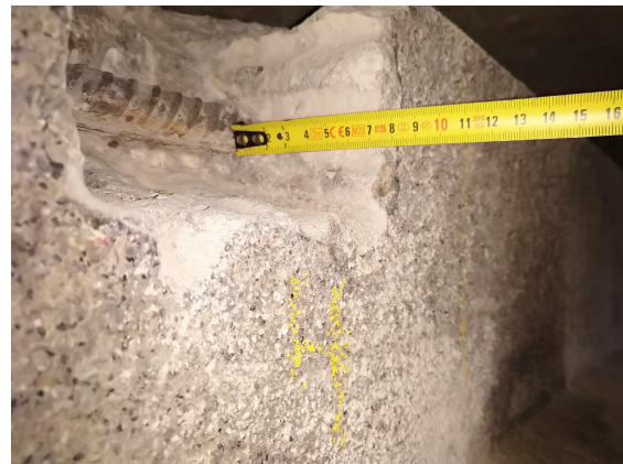
(d) Rebar location 4.
