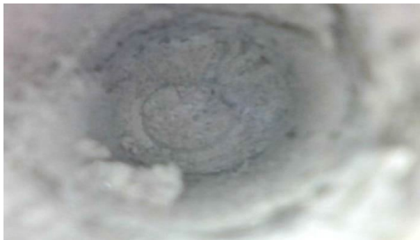
Figuur 4.10: Kijkgat locatie 23-A meetpunt 3.
